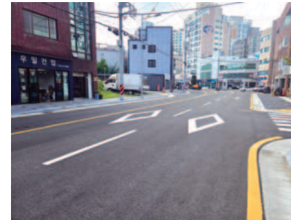
다대동 새마을금고 일원 도로 확장
