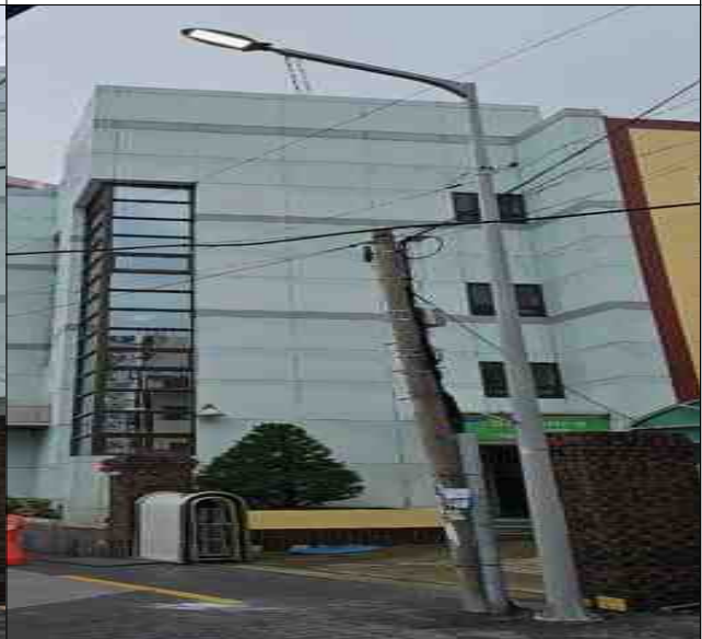
노후 가로등(FRP) 교체 후
