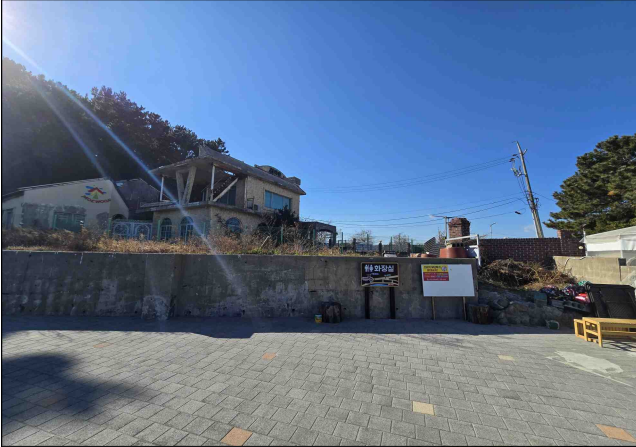
방범용 CCTV 신규 설치 전
